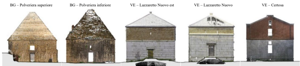
Fig. 4- Estrapolazioni nuvole di punti relative alle polveriere rimaste totalmente o parzialmente intatte
